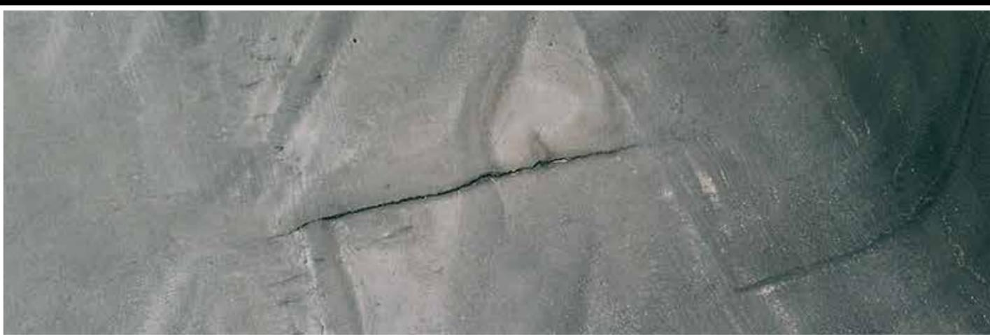
Ένα τυπικό παράδειγμα ρωγμής σε ένωση ασφαλτοπάνων προς επιδιόρθωση με **ElastiK** και **Supporto Antifessura** 150 gr/m<sup>2</sup> (πολυεστερικό μη υφαντό ύφασμα)
