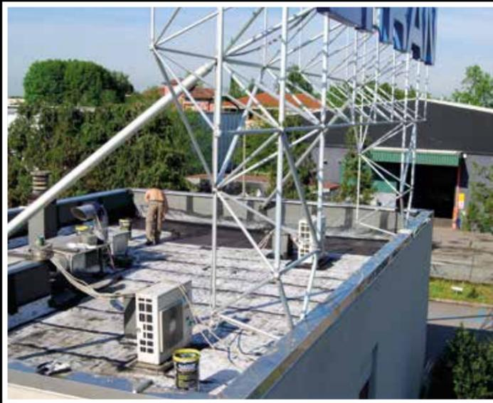
**Επιδιόρθωση ραφής μεταξύ ασφαλτικών μεμβρανών με **ElastiK** και **Supporto Antifessura** 150 gr/m<sup>2</sup> (πολυεστερικό μη υφαντό ύφασμα)**
