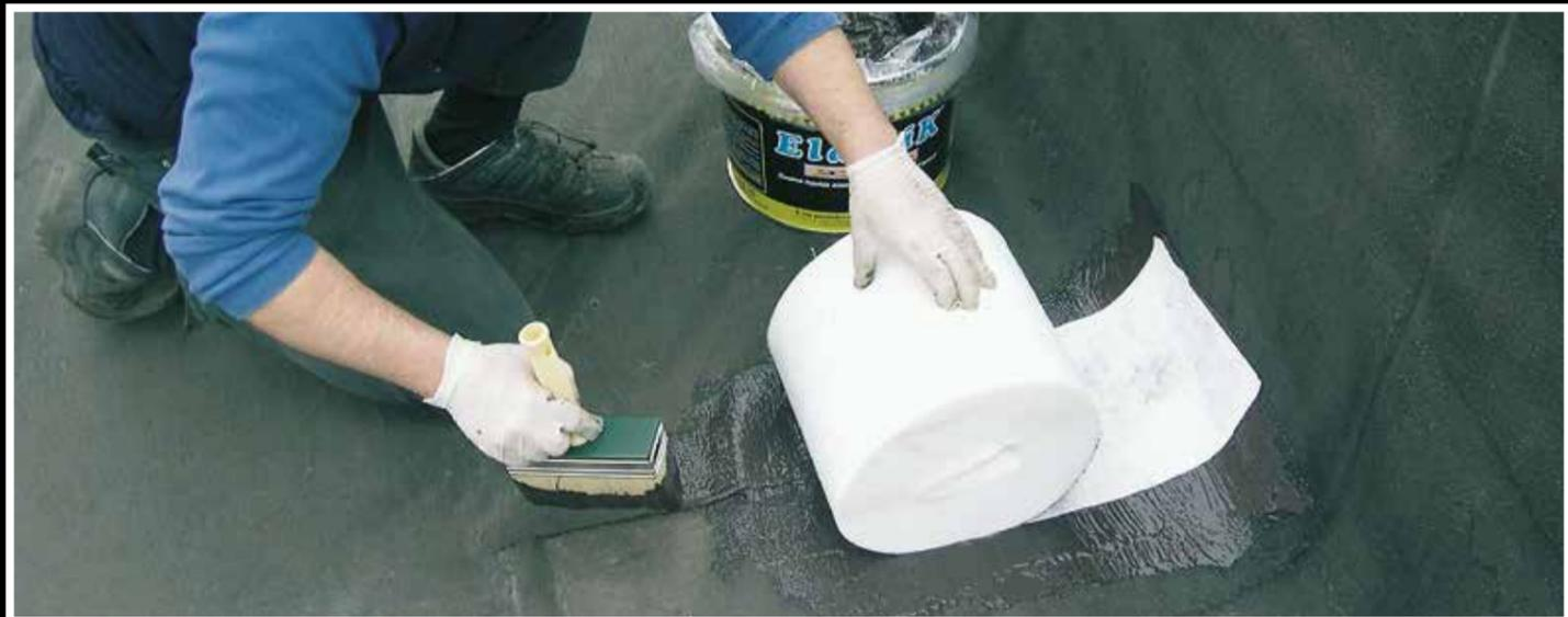
Χρησιμοποιούμε το **ElastiK** και το **Supporto Antifessura** (150 gr/m<sup>2</sup> πολυεστερικό μη υφαντό ύφασμα σε ρολό πλάτους 25cm) το οποίο τοποθετούμε κεντρικά πάνω από τη ρωγμή.
