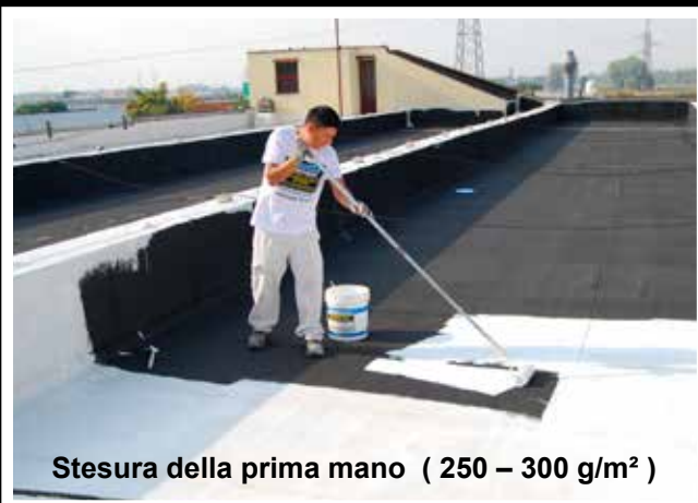
Impermeabilizzazione bituminosa di colore nero che in estate raggiunge una temperatura di 75° - 80°C
