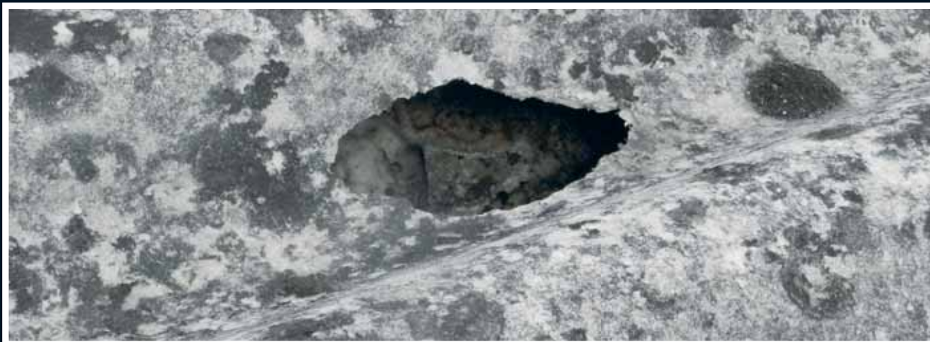
Evidente risultato della rottura della copertura in fibro-cemento per effetto delle grandine
