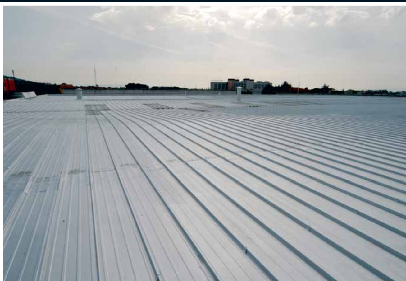
Aspetto della copertura metallica finita dopo il trattamento realizzato con una mano di vernice all'alluminio tipo Allumisol 12/14 stesa dopo 20 giorni dalla seconda mano di ElastiK (applicazione a spruzzo con un consumo totale di 200 g/m 2 )
