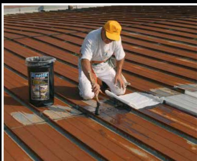
Fase di incollaggio con *ElastiK* del *Supporto Antifessura* in larghezza 50 cm (tessuto non tessuto di poliestere da 150 g/m<sup>2</sup>) sulle giunture delle lamiere o sulle parti di lamiera bucata
