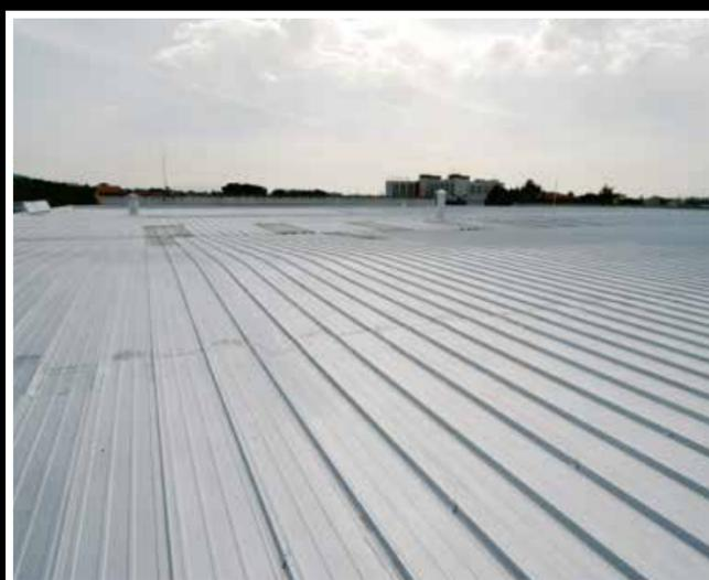
Aspetto della copertura metallica dopo l'applicazione di 1 mano di *Allumisol 12/14* (200 g/m<sup>2</sup>)
