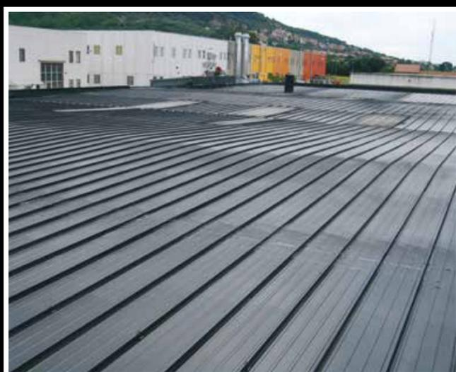
Aspetto della copertura metallica dopo l'applicazione di 2 mani di *ElastiK* (1 kg/m<sup>2</sup>)
