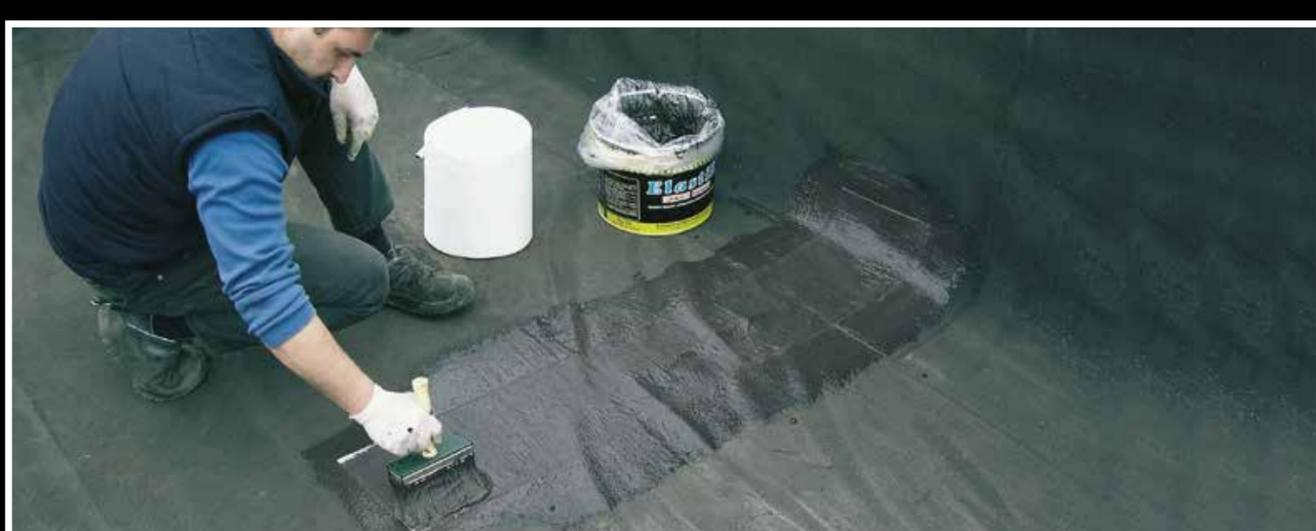
Verniciare con la prima mano di *ElastiK* il *Supporto Antifessura* fino a completa saturazione del suo spessore e dopo almeno 24 ore dare la seconda mano di *ElastiK*
