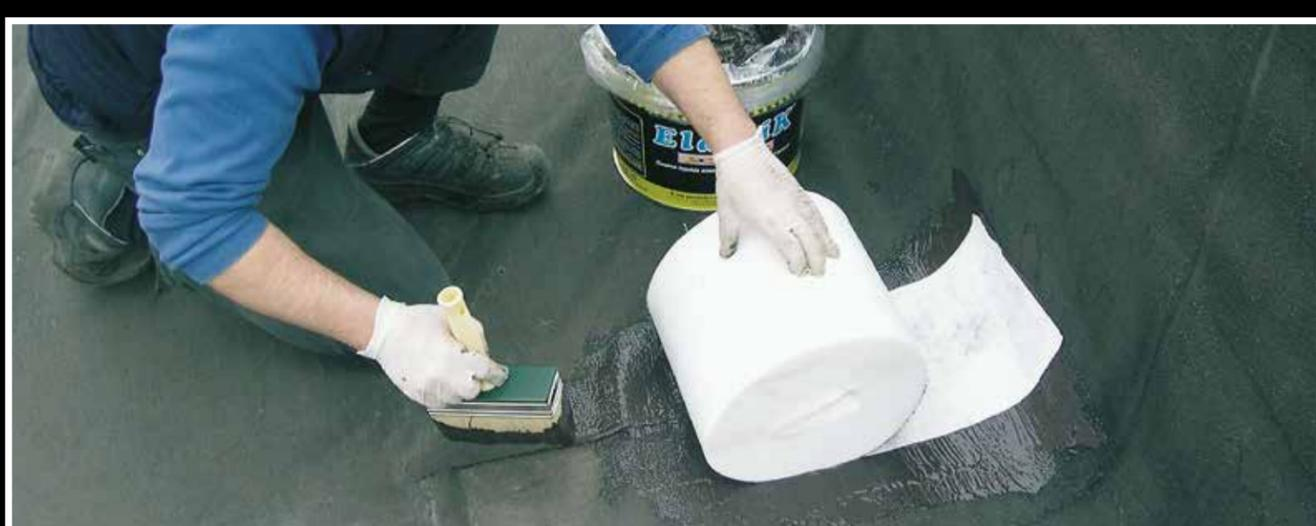
Incollare con l'*ElastiK* il *Supporto Antifessura* (tessuto non tessuto di poliestere da 150 g/m<sup>2</sup> usando il rotolo da 25 cm di larghezza) nel centro della saldatura da riparare
