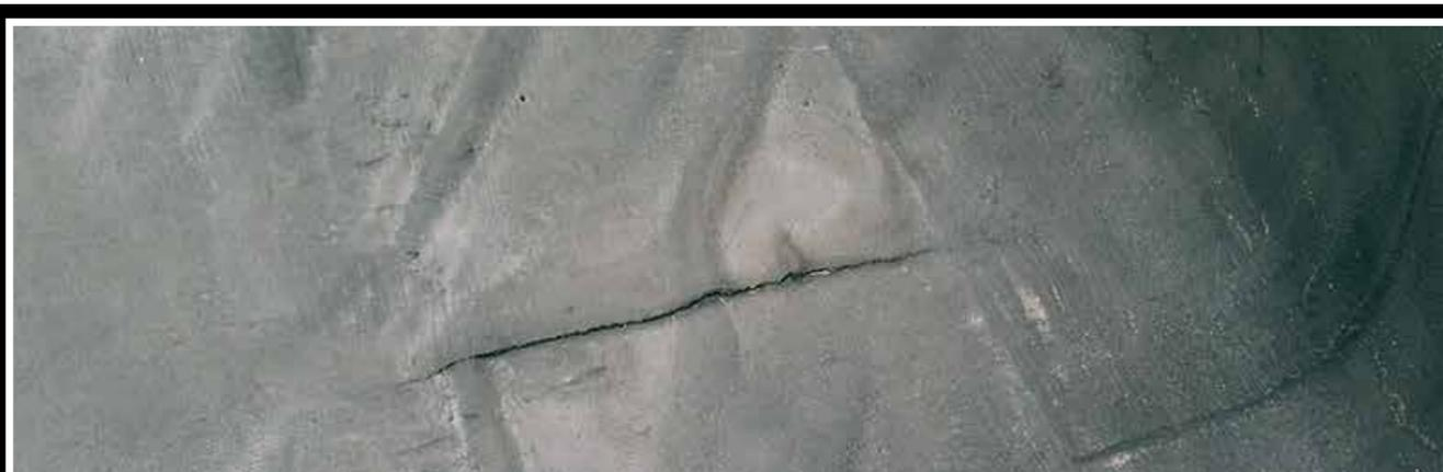
Tipico distacco di una saldatura fra due teli di guaina bituminosa in rotoli da riparare con *ElastiK* e *Supporto Antifessura* tessuto non tessuto di poliestere da 150 g/m<sup>2</sup>
