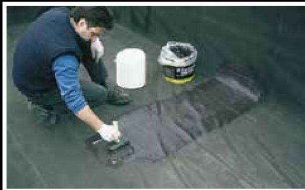
**Tipico esempio di riparazione di saldatura di testa fra due teli di Guaina bituminosa eseguito con **ElastiK** e **Supporto Antifessura** in rotoli da 25cm di altezza**
